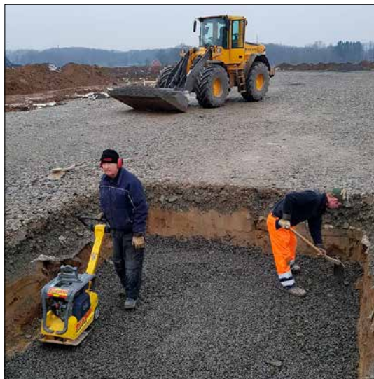
Plintgrunden förbereds. Min far Anders och min medarbetare Johan förbereder plintgrunden på potatisslaget.
