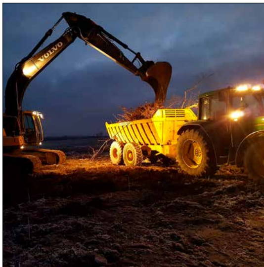
Schaktning. Här tar vi de första "spadtagen" på potatisslaget.
