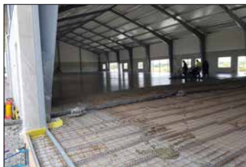
Golv gjutning. I mitten på maj, flera veckor försenat, blev det äntligen lämpligt väder för golv gjutning i potatislagret.
