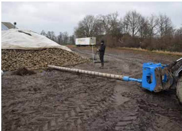
Rören monteras. I betor skruvas rören in med en modifierad dukrullare från Edenhall. I stärkelsepotatis kan rören tryckas in med pallgafflar.
