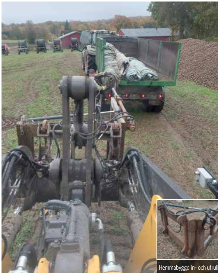
Bettäckning. Montering av TopTex duk för påläggning på råsen.
