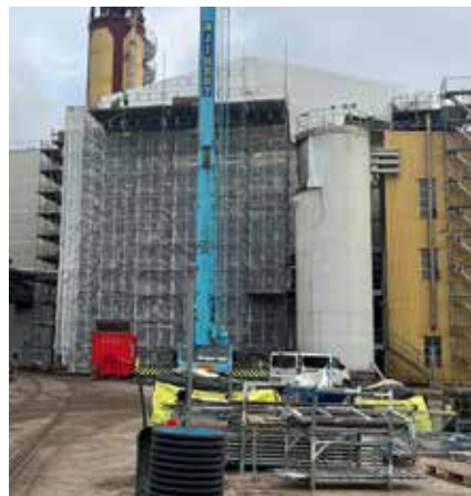
Inkapslat. Sockerhuset var tillfälligt inkapslat under resten av kampanjen.
